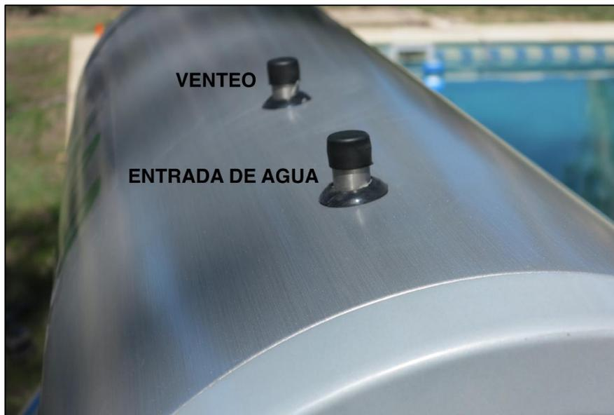
NOTA: La conexión de agua fría al termotanque solar se puede realizar tanto por la parte superior del termotanque solar (conexión 1/2", aro negro) como por la parte inferior (conexión 1/2", aro azul).
